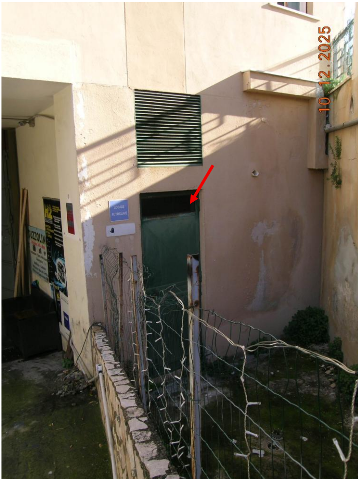
Foto 4 – La freccia indica il locale condominiale cisterna/autoclave
